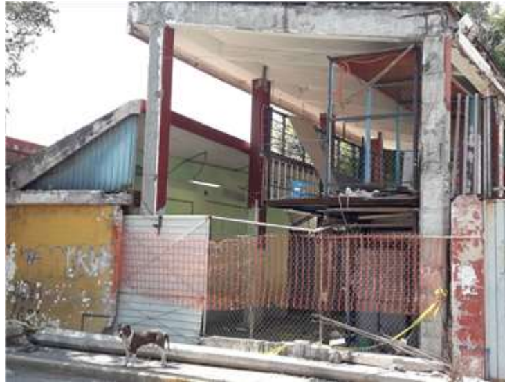
Aspecto de los daños en la Secundaria 31 Dr. Alfonso Pruneda, en el pueblo de San Gregorio Atlapulco, en Xochimilco, catalogados como daño moderado. Foto tomada en febrero de 2018.
