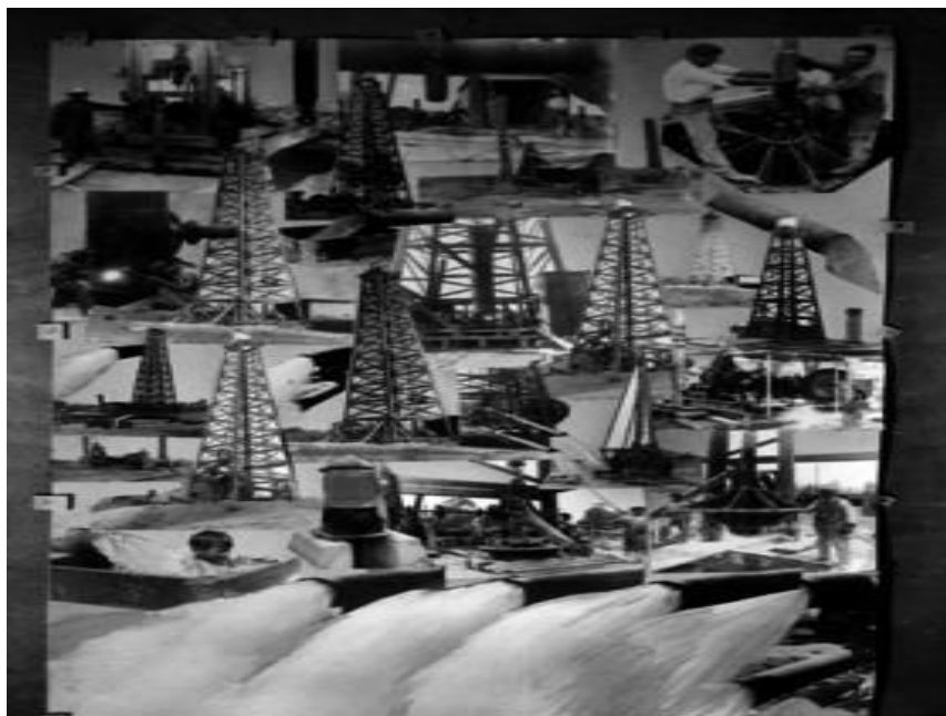
Imagen 6. La imagen muestra una alegoría fotográfica sobre obras hidráulicas y torres, existen hombres trabajadores en la perforación de pozos, al final un niño bañándose con el agua potable salida de la tubería. Fuente: Obras hidráulicas, composición fotográfica para cartel sobre obras, 16/09/2021, consultado: 07/08/2023, https://mediateca.inah.gob.mx/repositorio/islandora/object/fotografia%3A10256
