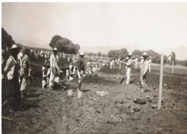
Imagen 8. Se muestra hombres trabajando a pico y pala a inicios de la obra de entubación del Río Chiquito que atraviesa la ciudad en 1930. Fuente: “El choque de la historia”, Morelia a través del tiempo, consultado el 12 de septiembre del 2024, http://www.moreliaatravesdeltiempo.com .
